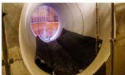
Platzierung – Pillow Plug sollte horizontal positioniert werden
