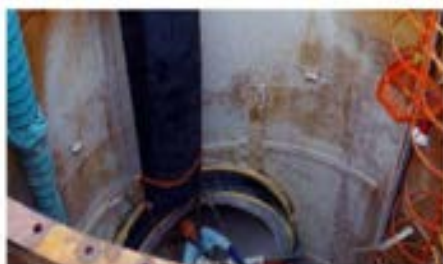
Einsetzen eines gefalteten Kissensteckers
